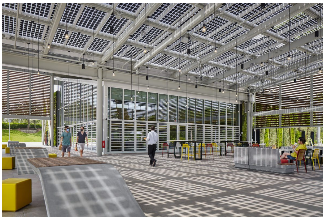
Imagem 06 – Fixação em cobertura de painel fotovoltaico integrado
