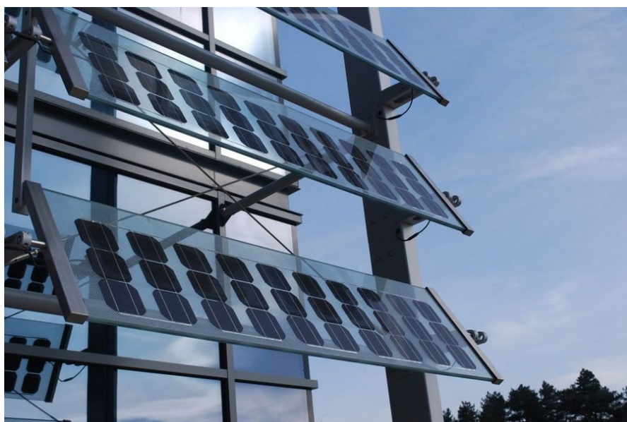
Imagem 02 - Aplicação de módulos fotovoltaicos em brises
